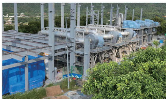
写真2 蒸発濃縮装置、晶析装置据付工事の様子
