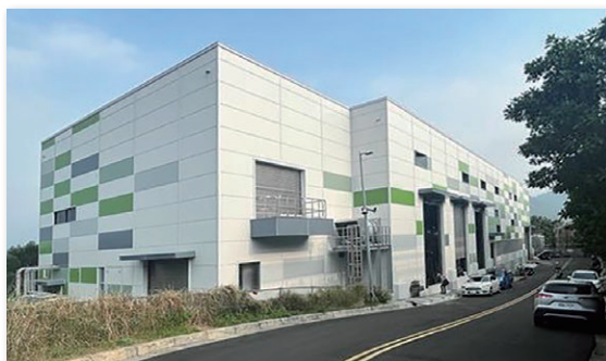
写真3 設備建屋外観
