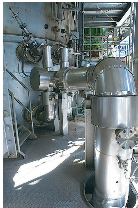
写真2 局所攪拌空気吹込み技術設置状況
