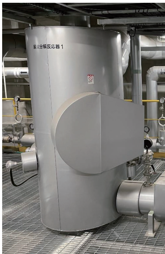
写真1 尿素分解反応器 外観(約2m×2m)
