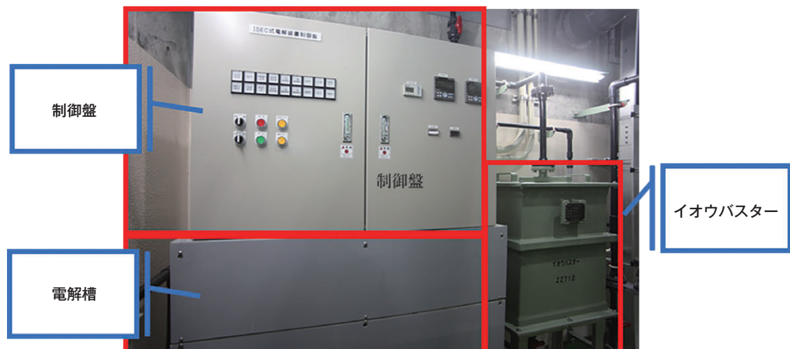
写真2 上部写真右部：電解槽・制御盤・イオウバスター
